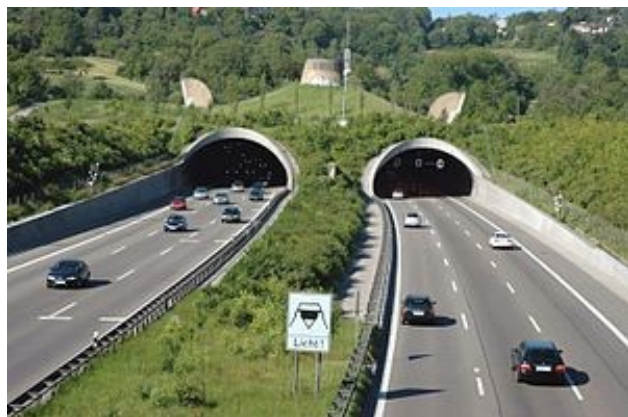
(Engelbergtunnel bei Leonberg Quelle: www.geolocation.ws)
